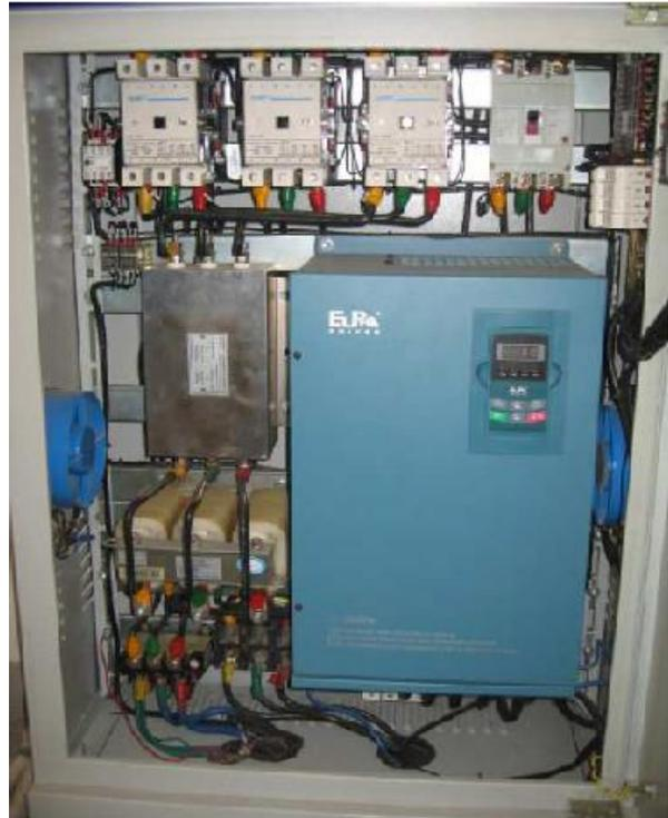
空压机节电控制设备内部结构
