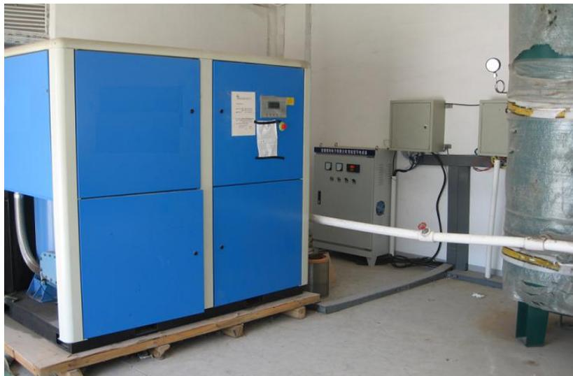
空压机节电控制系统
